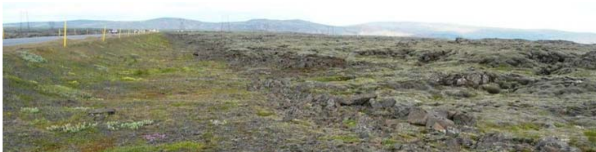
Mynd 4-23 Suðurlandsvegur á Hellisheiði. Grónar skeringar eru með öllum veginum.
